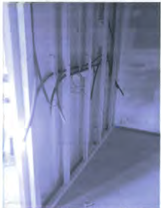
Außenplatten montiert → isolieren
